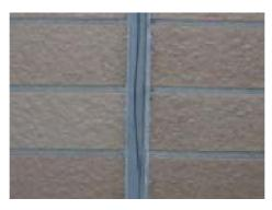
ロ) コーキング材の亀裂が浅い場合、浸透性下地補強材の塗布を行います。
