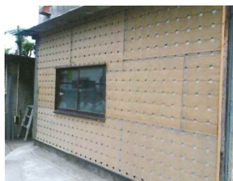
●SF通気ラスの留め付け
