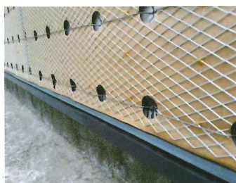
●SF通気ラスの張り始め
