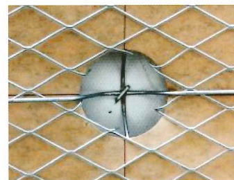
●力骨の交点をステーブルで留め付け
