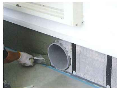
スチレンフォーム板への下地調整(基礎部)
