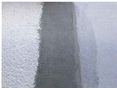
新旧モルタル取り合い部のクラック発生防止処置
